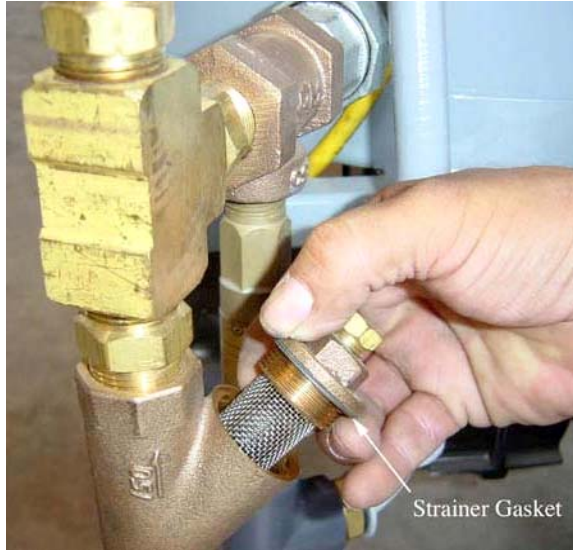
Fig. 3 Strainer Gasket
